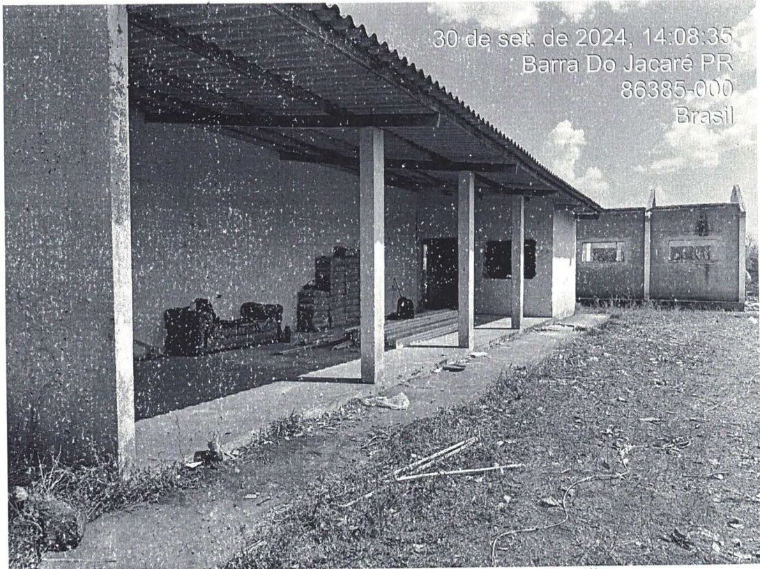
Figura 5 - COBERTURA BARRACAO ABERTO
